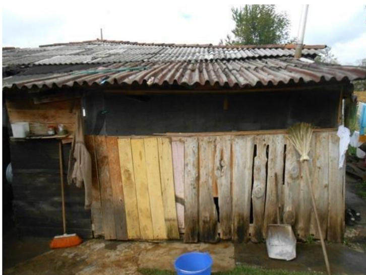
Figura 9. Cocina con techo de lámina de asbesto y lámina de cartón.
